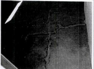
Fotografía N° 22: Fisuras reparadas en losas.
