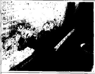
Fotografía N° 9: Nido de piedra o bolsón en muro de hormigón armado entre recintos de baño y cocina, vivienda A-102.
